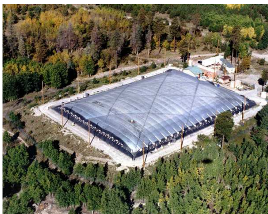
FIGURE 4: La piscine de l'expérience MILAGRO aux USA, pour la détection des gammas de très hautes énergies. Image tirée de [7].
